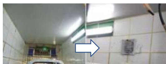
Gambar 5. Kondisi Sebelum dan Sesudah Instalasi Exhaust Fan
