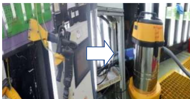
Gambar 6. Kondisi Sebelum dan Sesudah Instalasi Vacuum Cleaner
