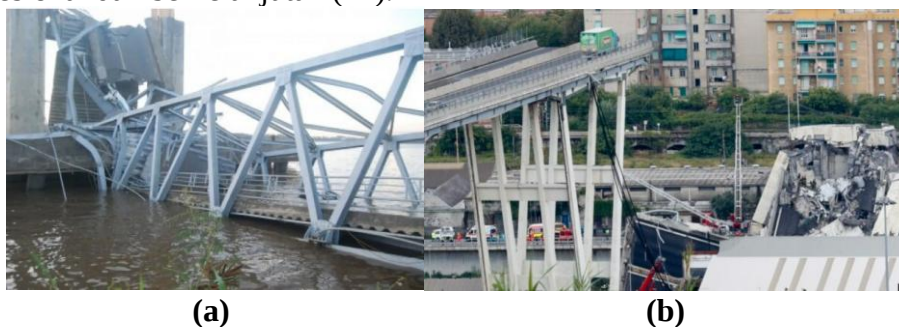
Gambar 3 (a) Runtuhnya jembatan Kutai Kartanegara 2011 (b) Runtuhnya jembatan Morandi Italia tahun 2018
