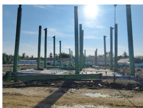
Gambar 5. Pemasangan Kolom
