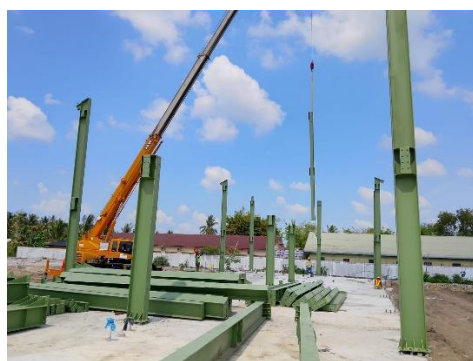
Gambar 5. Pemasangan Kolom
