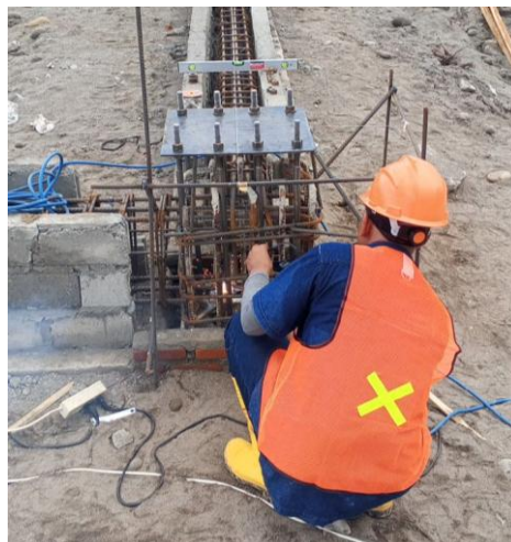
Gambar 4. Pemasangan Angkur
