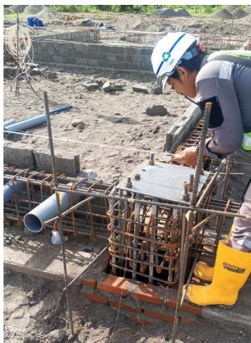
Gambar 4. Pemasangan Angkur
