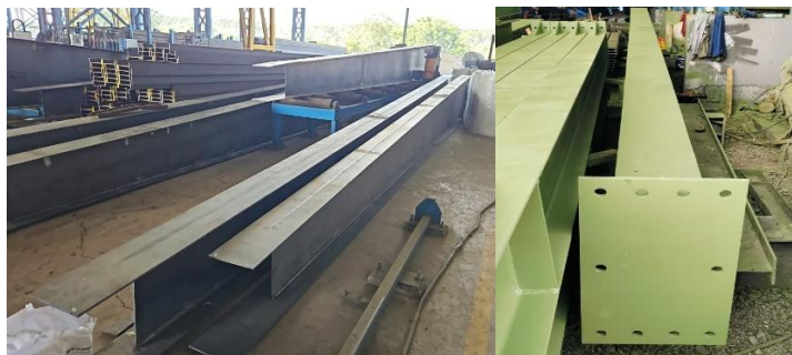
Gambar 2. Fabrikasi Baja di Workshop
