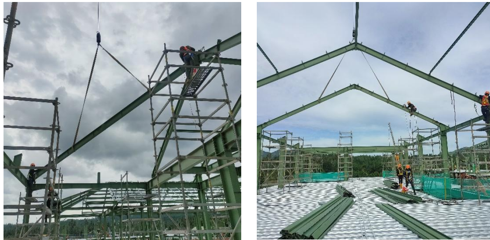
Gambar 7. Pemasangan Rafter
