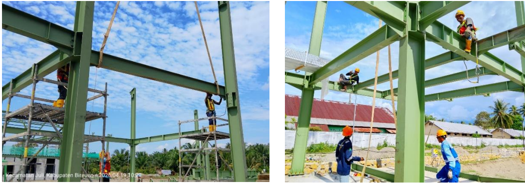
Gambar 6. Pemasangan Balok
