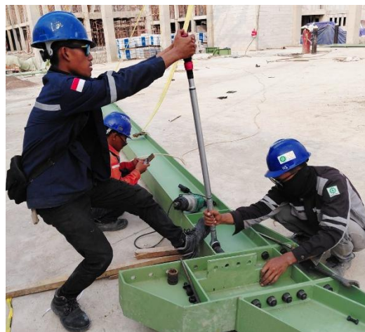
Gambar 8. Torsi Baut Sambungan
