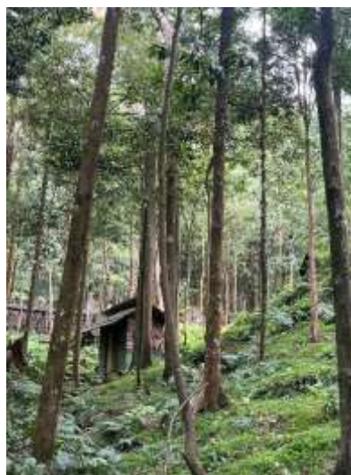
Gambar 3 Bangunan yang terbengkalai
